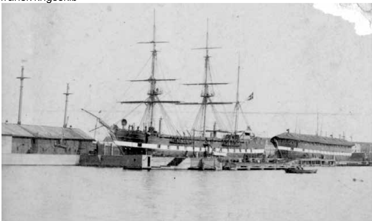
Skruefregatten Sjælland i Københavns orlogshavn. Fotoets datering ukendt. Den var vist bygget i 1858. Bagved ligger logskibet, hvor det indkaldte mandskab blev indlogeret, et tidligere orlogsskib, som var taget ud af drift. Foto lånt af Museet for Søfart, Helsingør.
