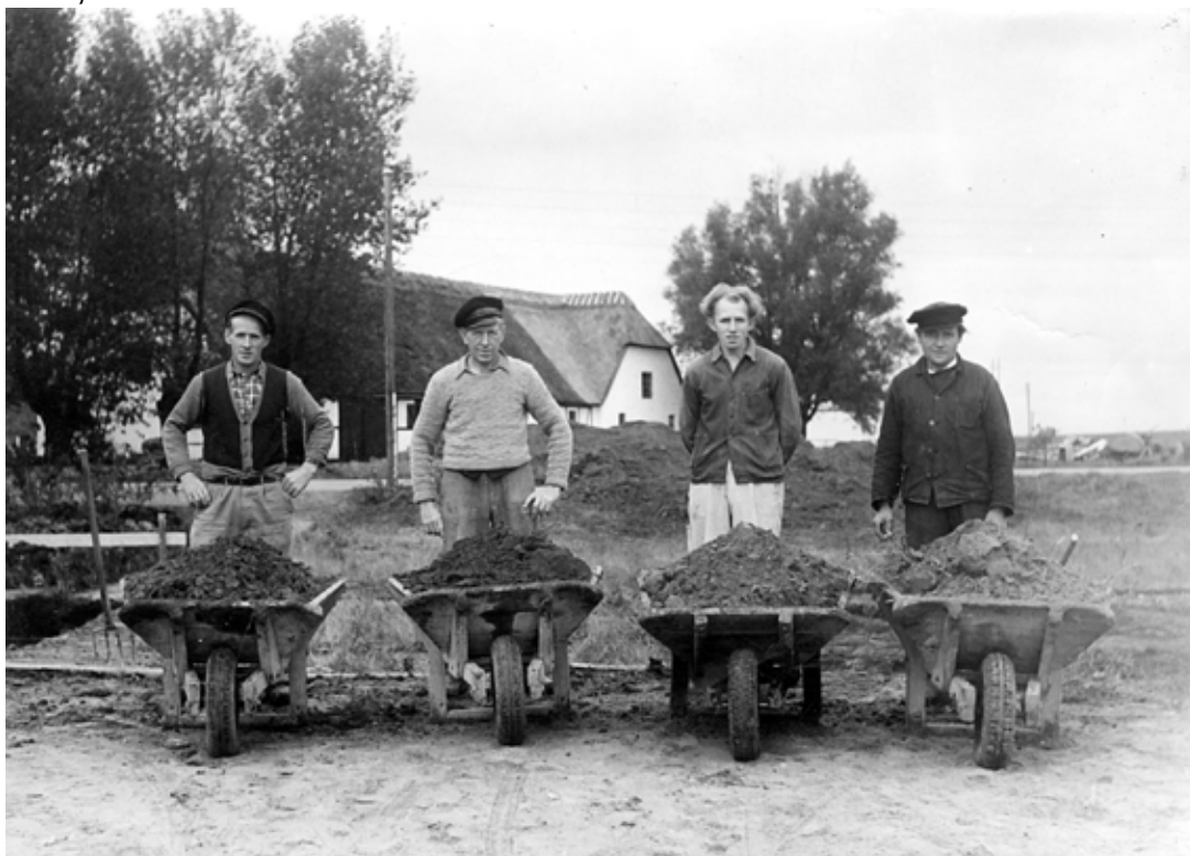
Jord- og betonarbejdere i 1954 ved opførelsen af ny skole i Skævinge, fra vestre brødrene Otto, Poul og Svend Aage Jensen. Sidste mand ukendt.
