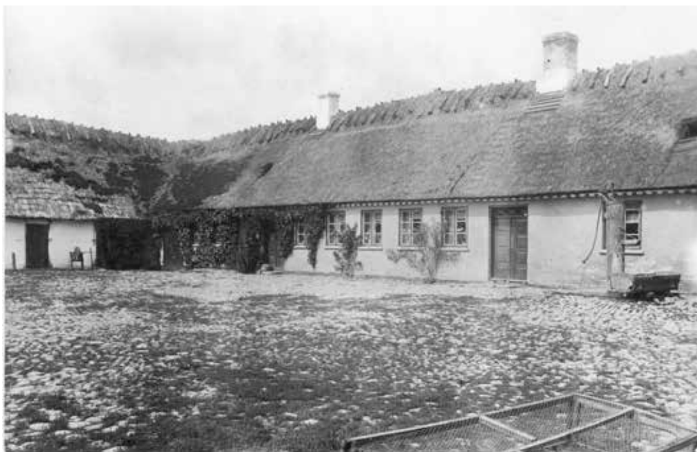
Stuehuset på Wendelholm i Knuds bedsteforældres tid med brønd, pumpe og vandtrug.
