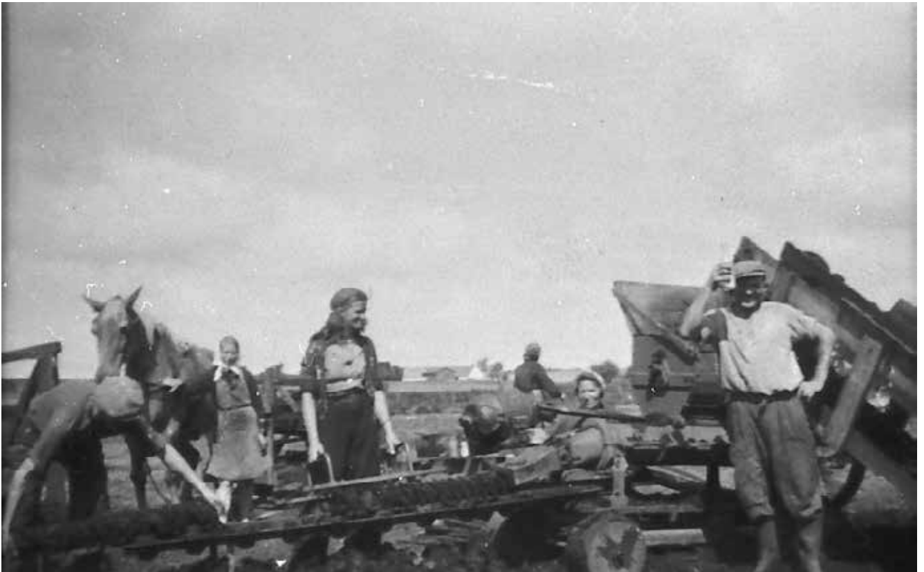
Inger Jørgensen tager fra, når de formpressede tørv kommer ud af maskinen.
